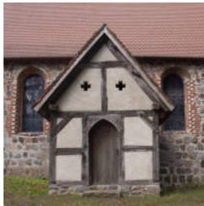
Abb.7 Kirche Berkholz, Boitzenburger Land, Anbau Südfassade; © Eva Becker
