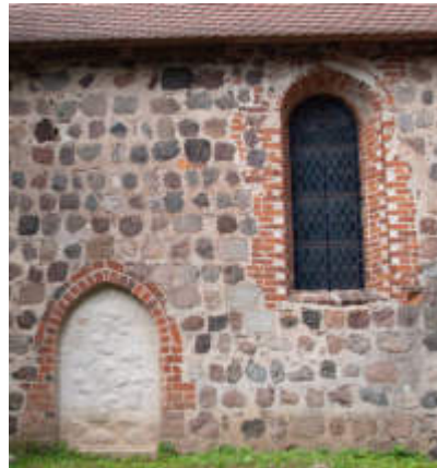
Abb.8 Kirche Berkholz, Boitzenburger Land, zugemauertes Portal und erweitertes Fenster in der Südfassade; © Eva Becker
