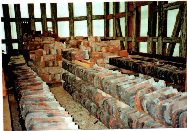
Abb. 3: Entkerntes Fachwerk mit Blick auf die Ostwand der Kirche Alt Placht (Foto: Sammlung Helmut Kliefoth)
